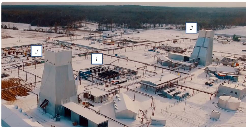
Рис. 3. Размещение шахтных стволов и замораживающего оборудования на промплощадке Петриковского ГОКа (конец 2016 г.): 1 – замораживающая станция, 2 – проходческий копр скипового ствола, 3 – проходческий копр клетьевого ствола
